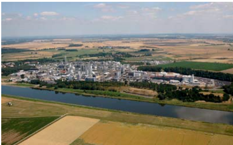
Wacker Chemie AG Nünchritz
