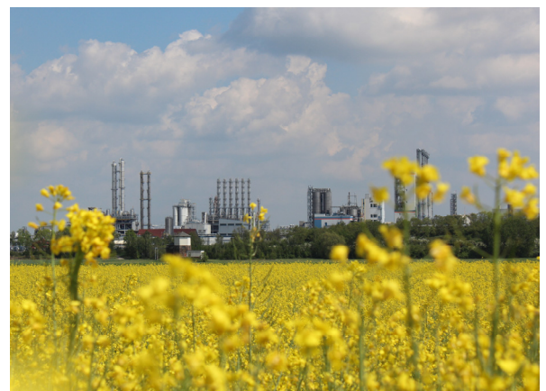
Wacker Chemie AG, Nünchritz
